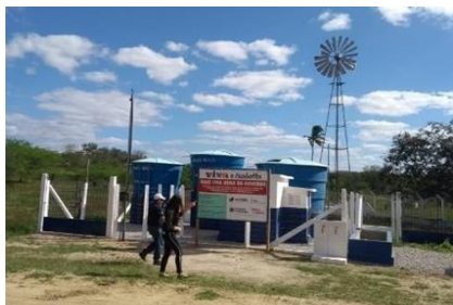
Foto 2 - Sistema de dessalinização junto ao campo irrigado por cata-vento. Riacho de Santo Antônio (PB). Crédito: Arquivo institucional do PROCASE / 2019.
