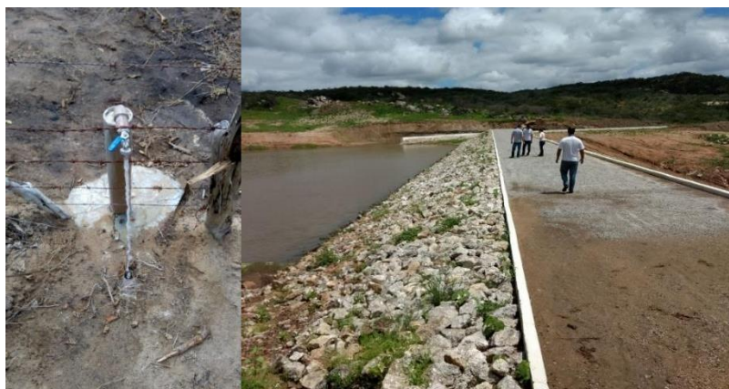
Foto - Estratégias de segurança hídrica apoiadas pelo PROCASE. À direita: grande barragem para captação de água superficial (Riacho Fundo, município de Tenório). À esquerda: poço tubular profundo instalado em comunidade beneficiada. Fonte: PROCASE, 2019.
